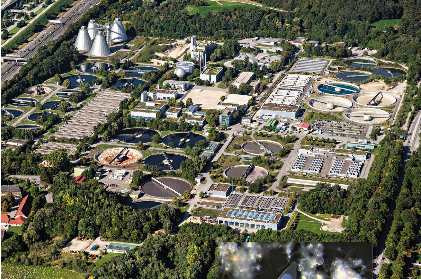
Blick auf die Kläranlage von Gut Großlappen.
