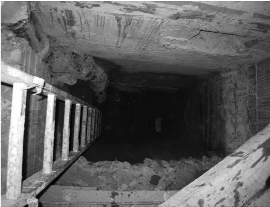
Bodenöffnung im Untergeschoss des Brandabschnitts D.
